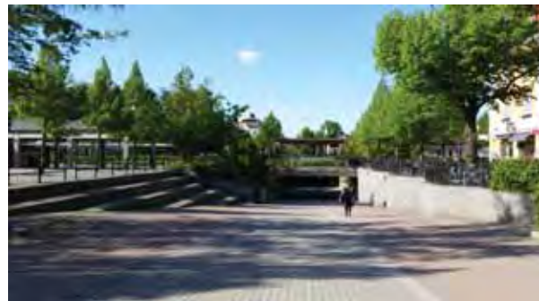
Tunnel under järnvägen med bred gång- och cykelbana.
