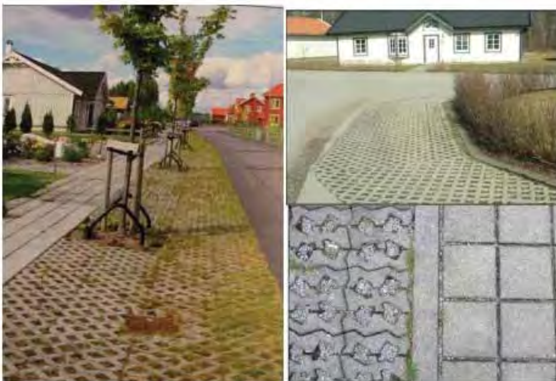
Exempel på infiltrationsstråk med rasteryta, från dagvattenutredningen (Bjerking, 2021).
