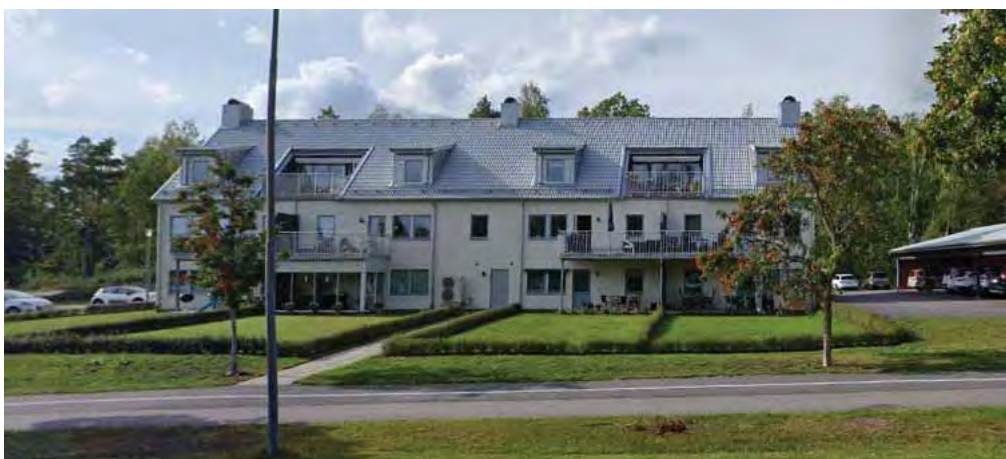
Foto från Kerstinbodagatan på en av byggnaderna i kvarteret Lien (Google maps).
